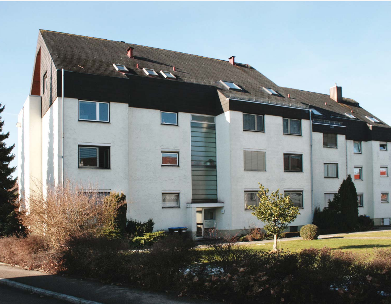
Hausansicht Eingangsseite Nordostflügel, Germanenstraße 1 und 3
