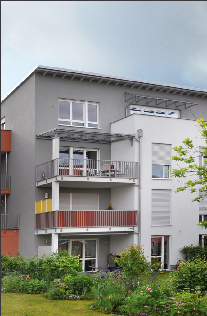
Neubau der attraktiven Wohnanlage „Trias“ im Prinz-Karl-Viertel, Augsburg
